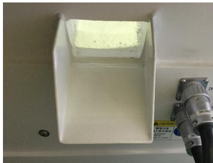
装置背面ドレン
